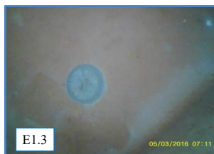
E1.3: Scatto eseguito a circa 10 cm da inizio foro: laterizio forato
